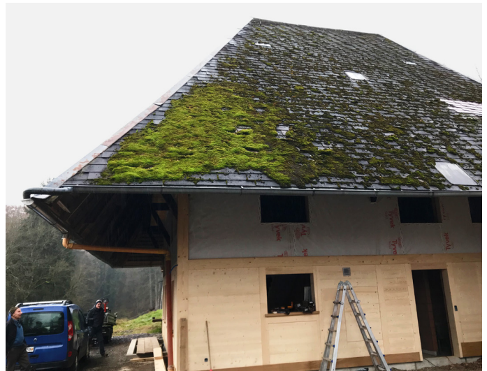
Breitenegggrain im Umbau 2023
