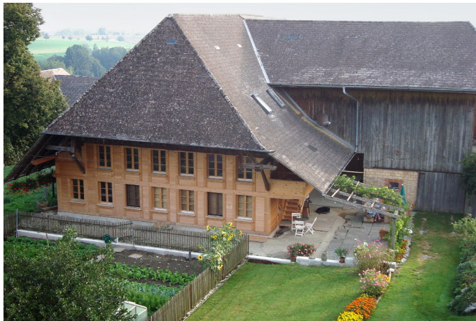
Hof Zürcher Hübeli nach der Renovation von 2008
