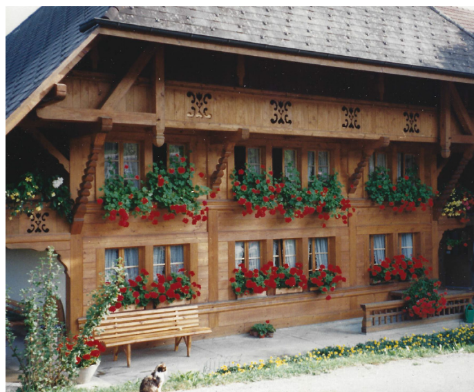
Hausfassade Weiermatt nach dem Umbau 1983
