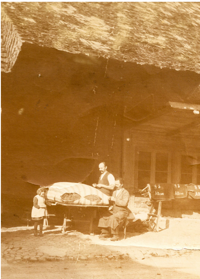
Alte Sattlerei Schärer an der Dorfstrasse bis ca. 1923.
